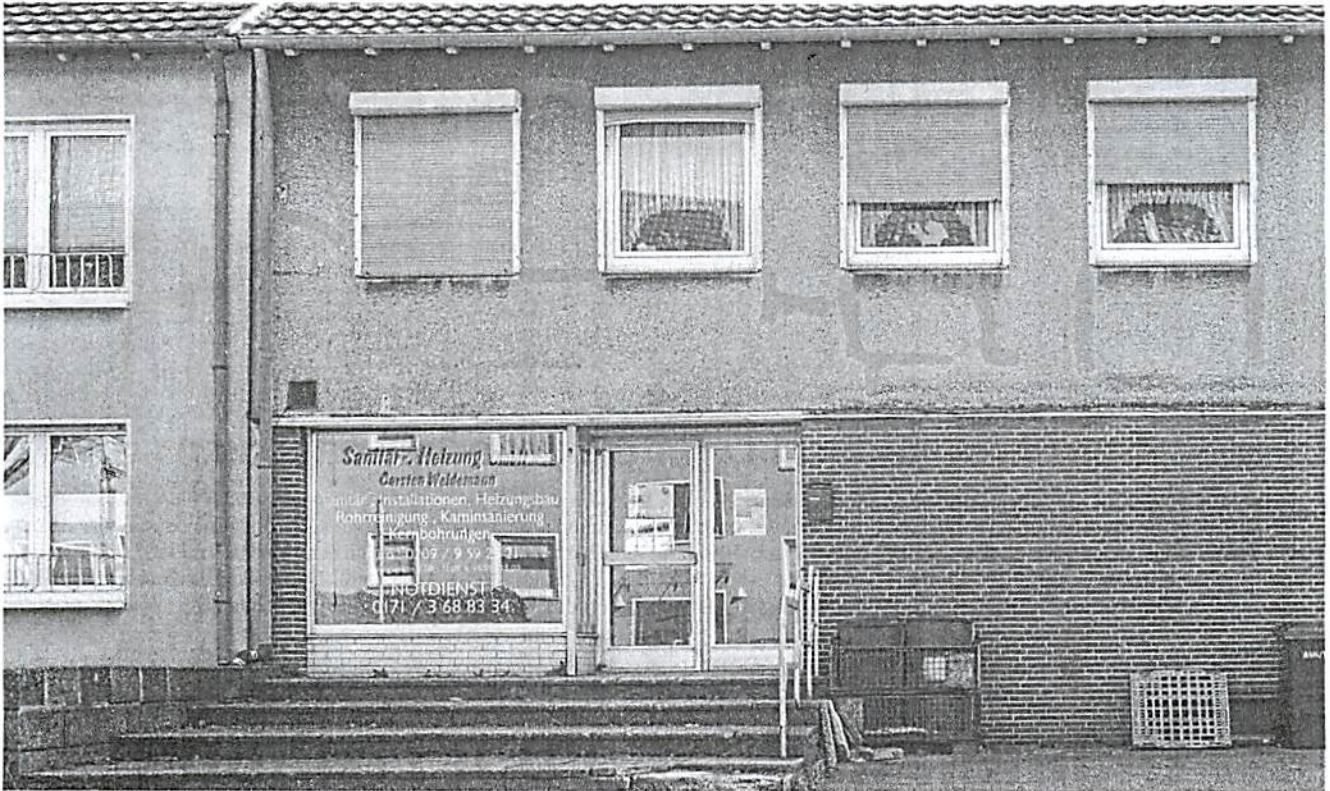
In dem Gebäude an der Giebelstraße 7 soll der Quartierstreffpunkt Schaffrather Mitte entstehen.
